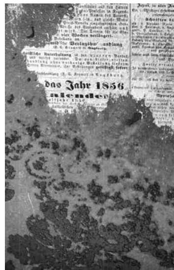
Prilog 3. Sloj novina ispod tapeta na jugozapadnom zidu
