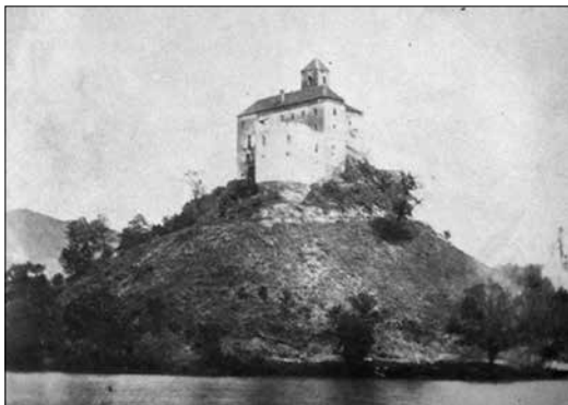
Prilog 8. Trakošćan s jezera (prije obnove)
