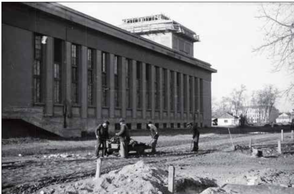
Slika 11. Dvršeno ulično pročelje (vanjska fasada) (HR-DAOS-965. Zbirka Plevnik, 168, sl. 12)
