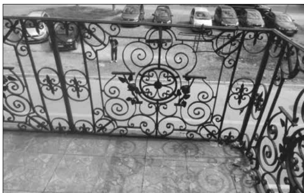
Slika 7.: Originalna ručno kovana ograda na balkonu stare pošte. Slikano srpnja 2023. godine. (Zbirka autora.).
